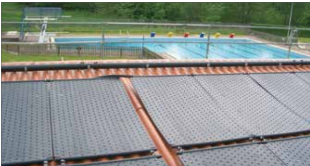
Dachmontage Freibad Knüllwald-Remsfeld
