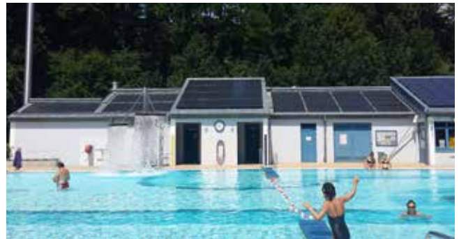
Dachmontage Freibad Mühl Dorf am Inn
