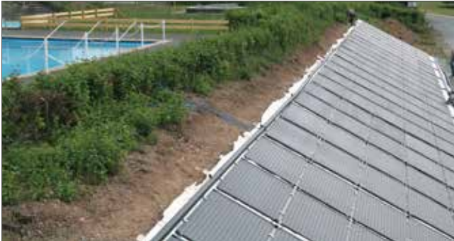
Freiflächenmontage Freibad Niedereisenhausen
