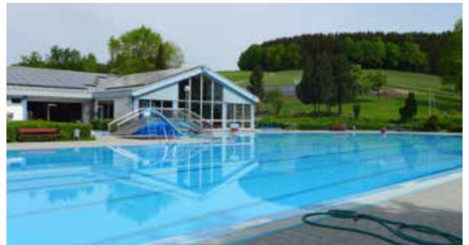
Dachmontage Freibad Gramming
